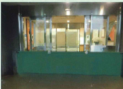
止水シートの設置※2
