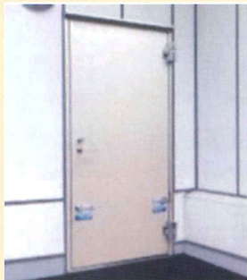
防水扉の設置※2
