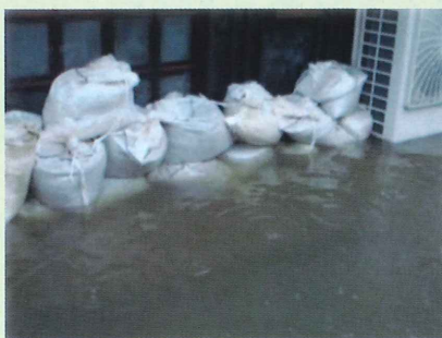
土のうの設置※1
