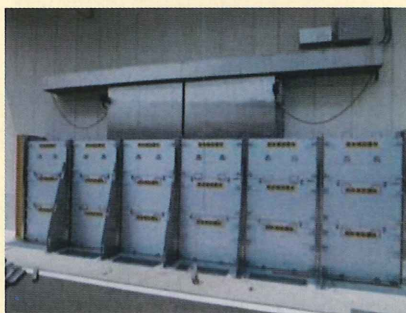
止水板の設置※4
