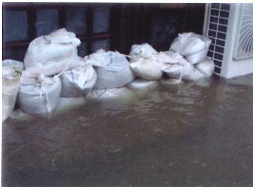
土のうの例（画像出典：「土のうによる水防対策」（江戸川区土木部））
