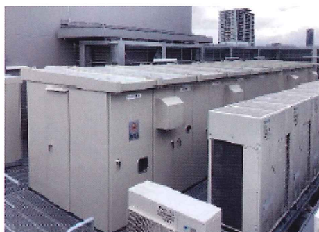
受変電設備を屋上に設置した例、受水設備のかさ上げの例 (画像出典：建築物における電気設備の浸水対策ガイドライン)
