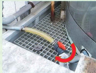
逆流防止(弁の閉鎖)※3
