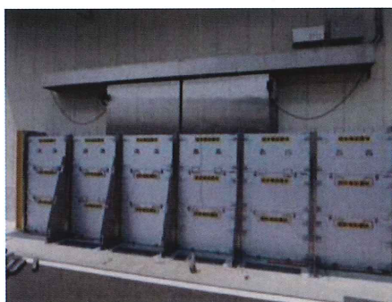
脱着式止水板（連続構造）の例
