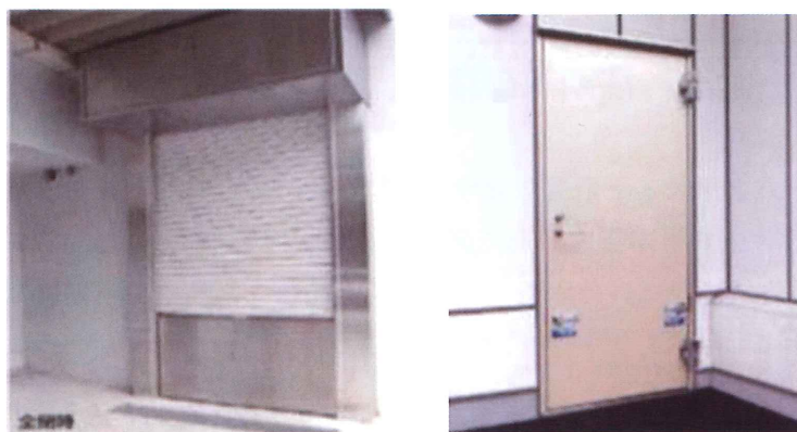
防水シャッター、防水扉の例 （画像出典：建築物における電気設備の浸水対策ガイドライン）
