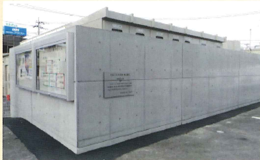
受電設備の囲い塀の設置※2
