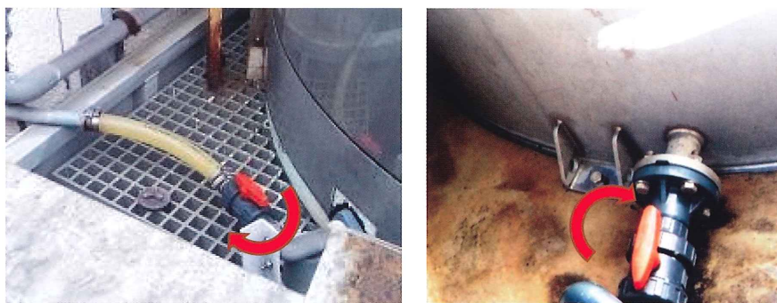
画像は開状態。閉状態にする。(画像出典：震災対策マニュアル)
